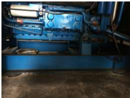
柴油发电机房基础减振
