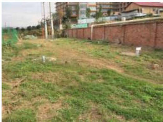
地埋式污水处理站
