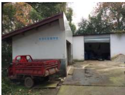
生活垃圾暂存间
