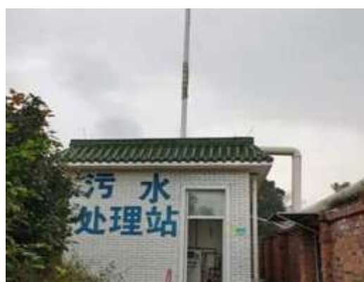
污水处理站用房
