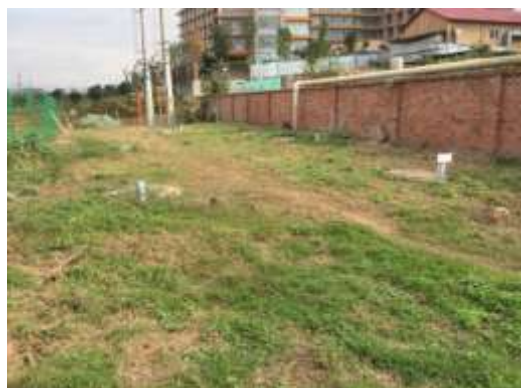
地埋式污水处理站
