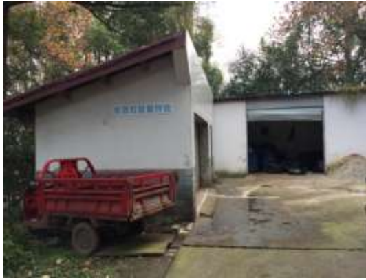
生活垃圾暂存间
