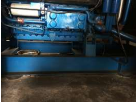
柴油发电机房基础减振
