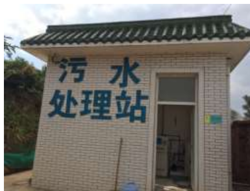
污水处理站用房
